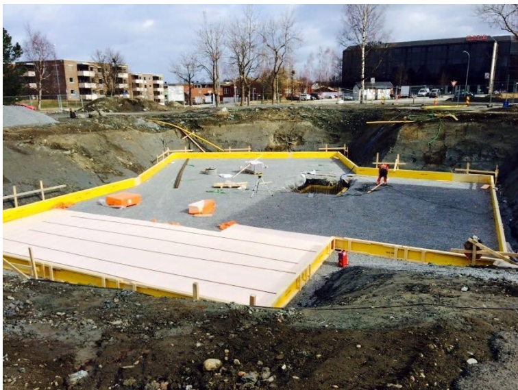
Det første studentboligtårnet ferdig fundamentert
