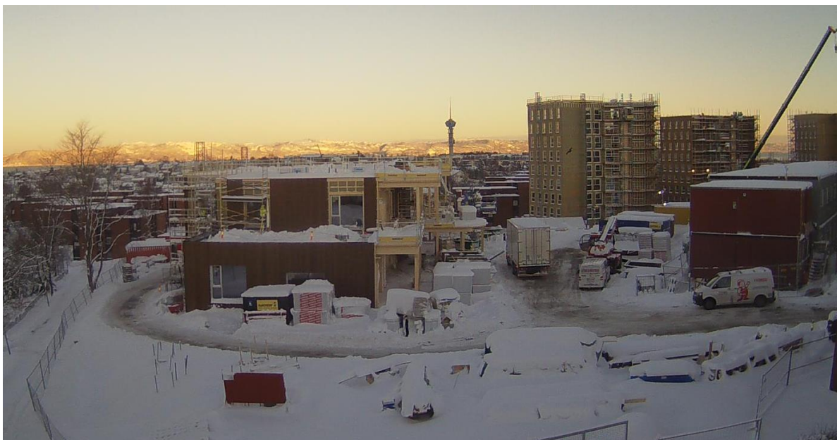
Bilde 2 Bilde fra byggeplasskamera, barnehagen og tre tårn vises
