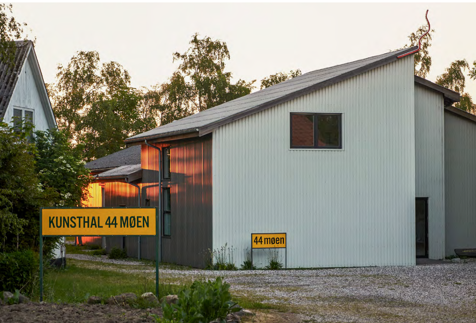
Kunsthall 44Møens nuværende udstillings- bygning i et tidligere autoværksted.
