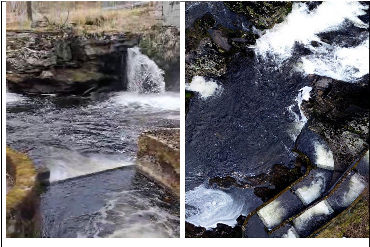
Figur 27. Inngang til trapp (t.v.) og dronebilde av nedre del av trapp i Bøfjordelva (t.h.).
