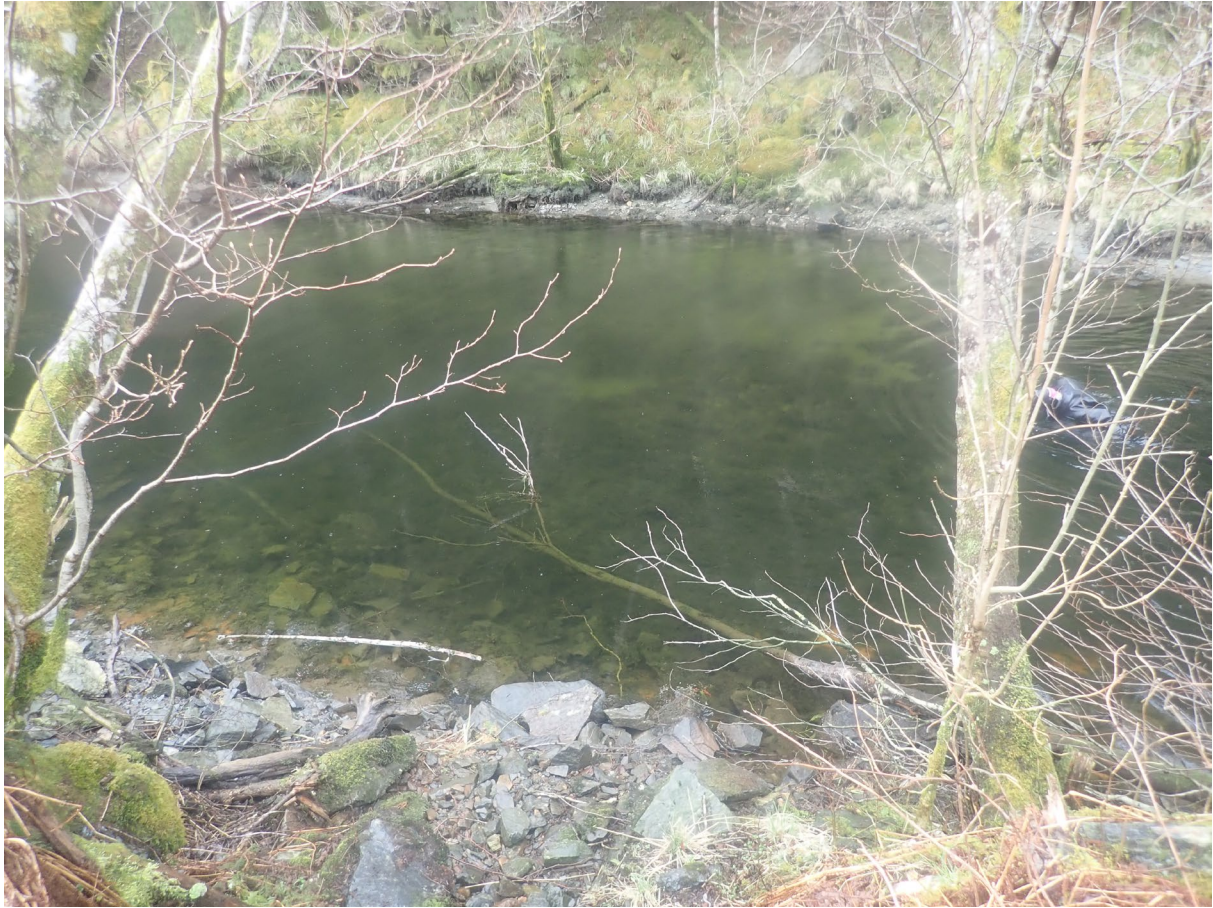
Figur 18. Senket og utvidet kanal mellom Staurdalsvatnet og Stigestrandsvatnet. Stein i kantene gir skjul for ungfisk og midt i kanalen ligger en stripe med grus egnet for gyting.
