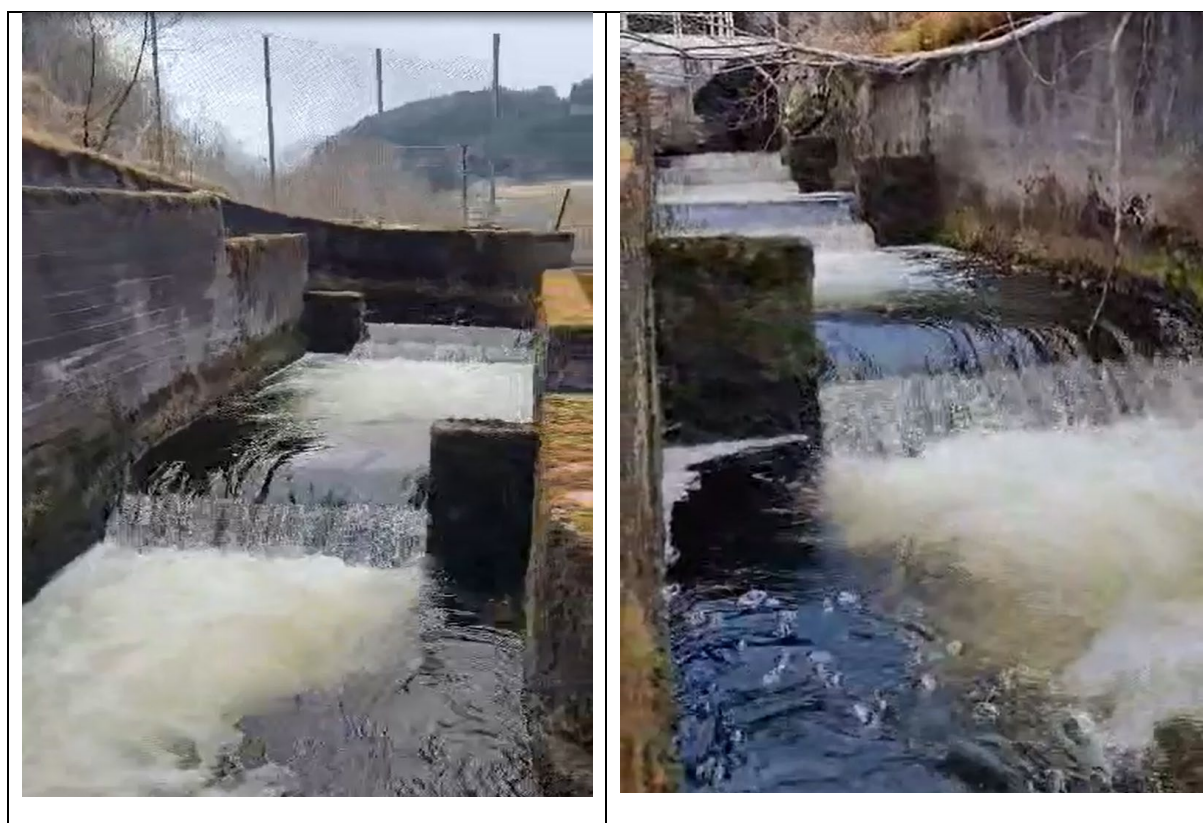
Figur 26. Betongen i trappen i Bøfjordelva ser ut å være i god stand.
