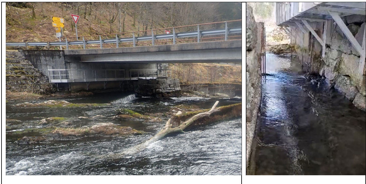
Figur 28. Utgang trapp under veibro i Bøfjordelva.
