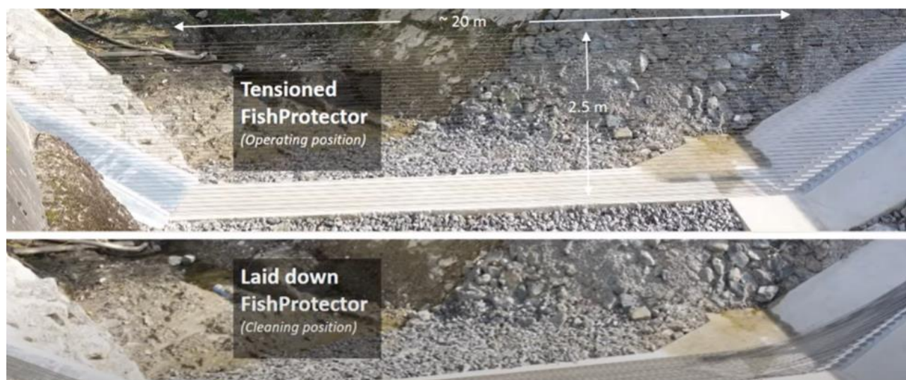
Figur 4-3. Oppspent (driftsmodus) og slakket (rensemodus) posisjon på elektrisk wire-grind. Figur er klipt ut fra presentasjon til FishProtector.
