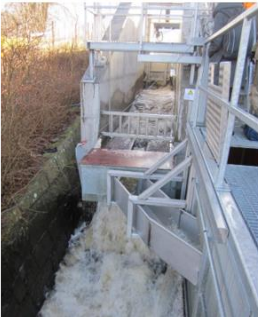
Figur 4-5. Finnist i fiskeavlederen ved Herting kraftverk i Ätran. Formålet med rista er å skille ut nedvandrende fisk fra vannet, ved at fisken sklir oppå rista ned i en oppsamlingsrenne som føres til et oppsamlingsbasseng. Foto: Norconsult Sverige.
