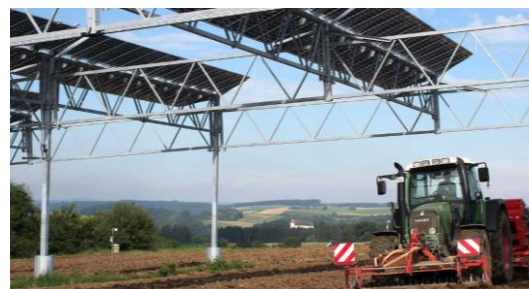
Nya, icke-inträngande applikationer av solcellsparker. Ovan: Agri-PV där solcellspanelerna monterats antingen lodrätt eller högt för att inte hindra brukandet av marken under.
