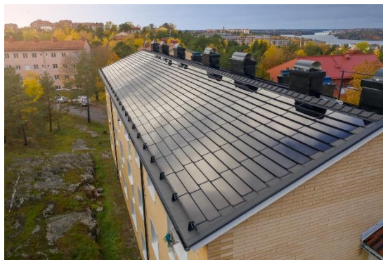
Soltech Shingel, en modern takpanna med fullt integrerade solceller.
