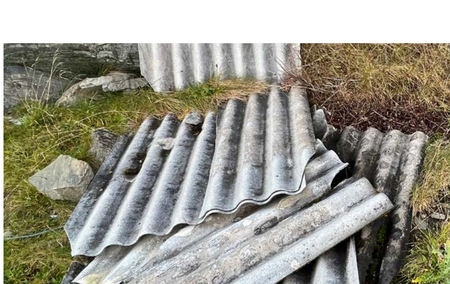
Takplater av eternit.
