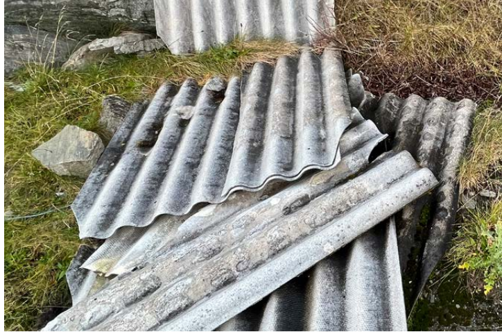
Takplater av eternit.
