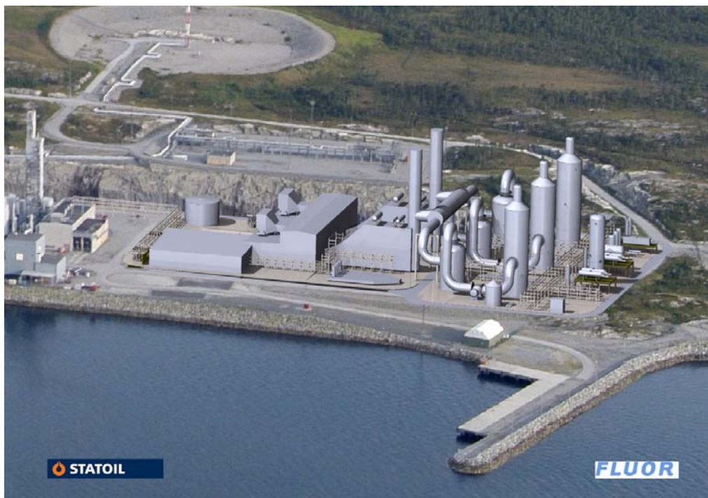
Figur 2-3. Montasje som viser CO 2 -fangstsanlegg på tomte vest for (til høyre for) kraftverket.
