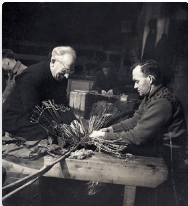
Cable work in Lofoten. Unknown photographer and year. Courtesy of LM Ericssons historiska arkiv, Centrum för Näringslivshistoria.
