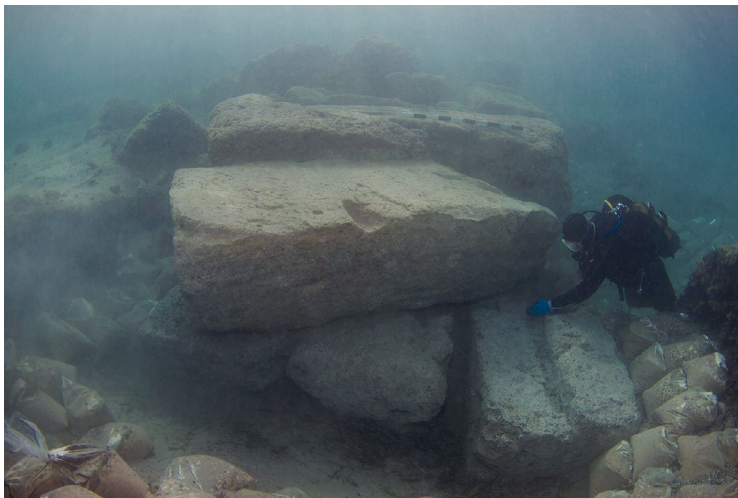
Fig. 5. Det nordvestlige hjørne af Mole L-M4. Mads Møller Nielsen udpeger den fundamentudskæring, som den meget store blok ovenover oprindeligt hvilede i (Foto: V. Tsiairis 2015)
