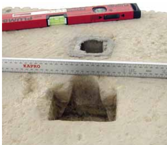
Fig. 18. Oversiden af "to-søjlemonumentets" ene kapitæl. Der ses både et løftehul af den østgræske type og et dyvelhul med rester af bly, hvormed noget har været fastgjort til kapitælets overside.
