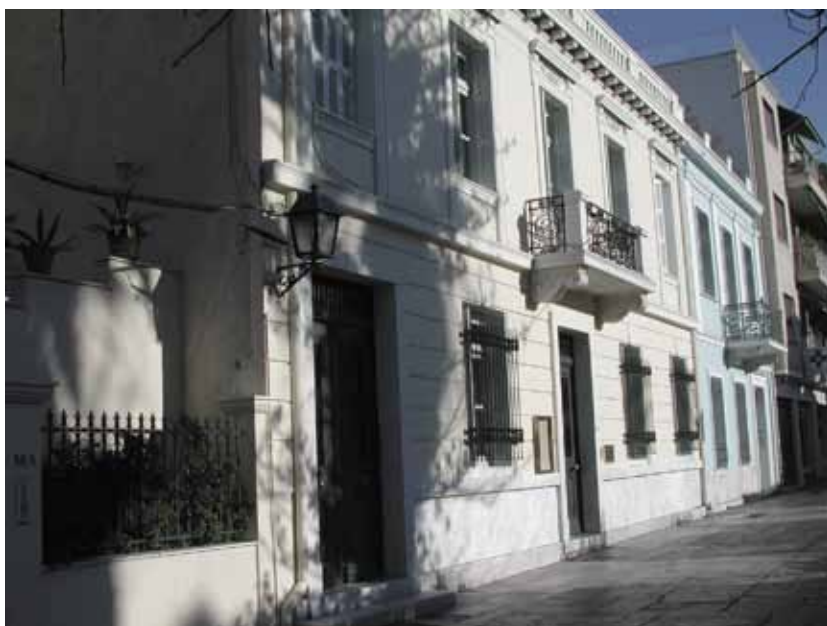
Facaden på Det Danske Institut fremtræder igen som skinnende ny efter hærværket i december 2006.
