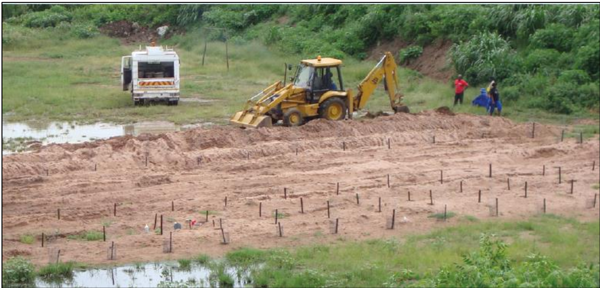
Zanjas profundas de letrinas de fosa para lodos fecales en Durban, Sudáfrica (Fuente: Jay Bhagwan, Water Research Council South Africa en Strande et al., 2014)
