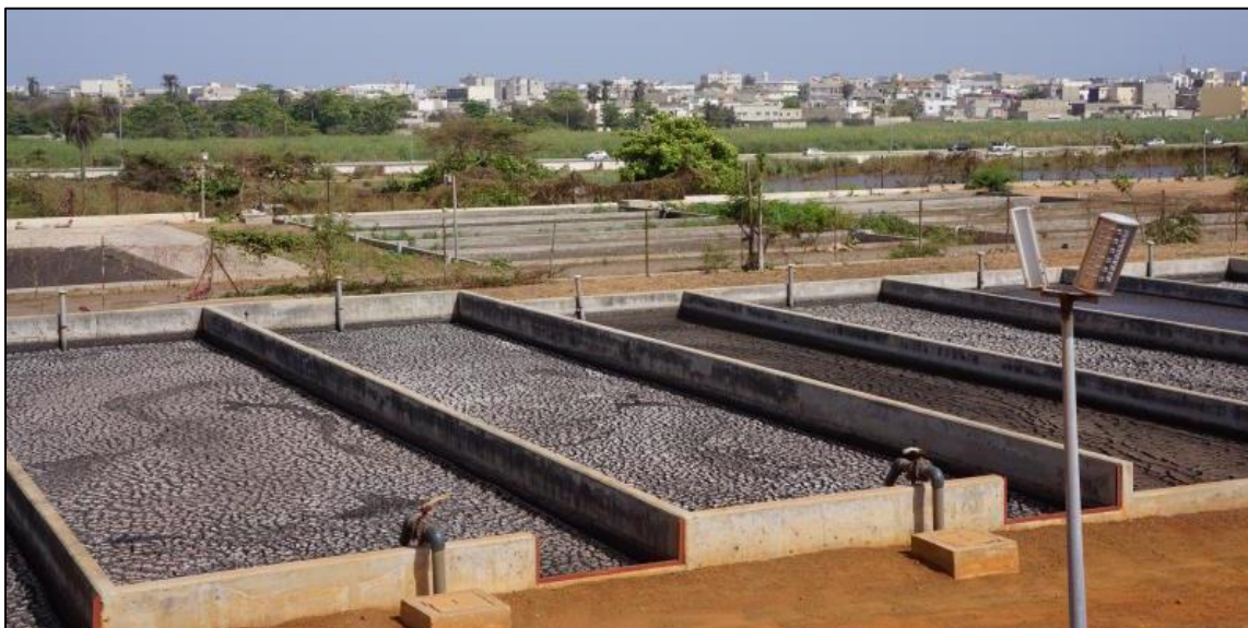
Lechos de secado sin plantas en una planta de tratamiento de lodos fecales en Dakar, Senegal (Fuente: Eawag-Sandec)
