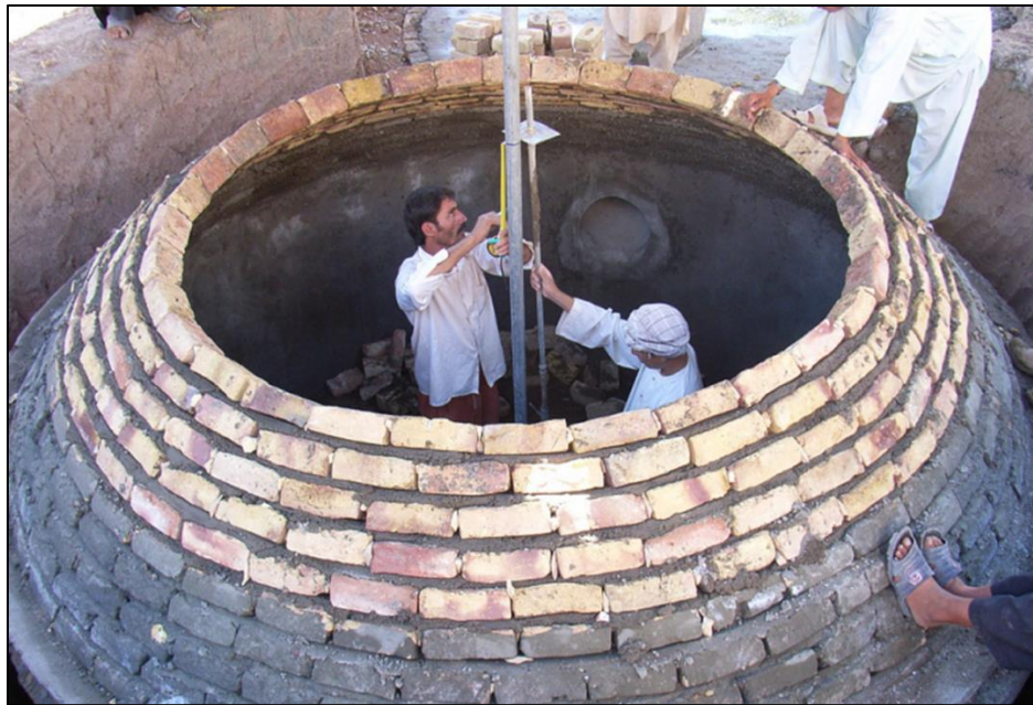
Digesteur anaérobie en construction en Afghanistan (Source : SuSanA)
