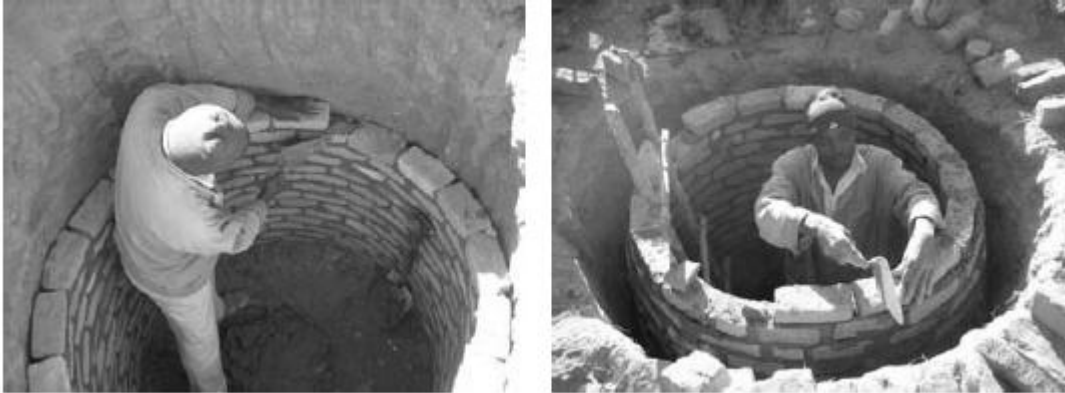
Revêtement d'une fosse avec des briques (Crédit : Morgan, 2011)
