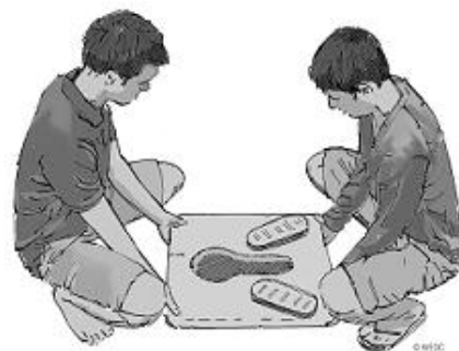
Installation d'une plateforme SanPlat (Crédit : Shaw/WEDC, 2013)
