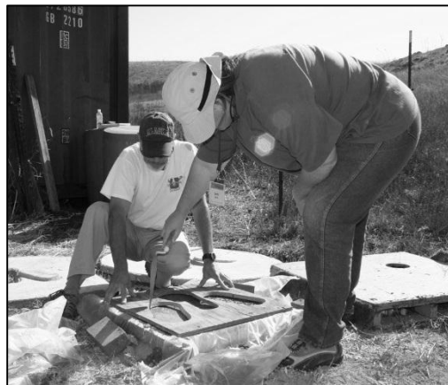
Guide en bois artisanal pour positionner le repose-pieds au bon endroit (gauche) ; traçage de la position des repose-pieds à l'aide du guide (droite)
