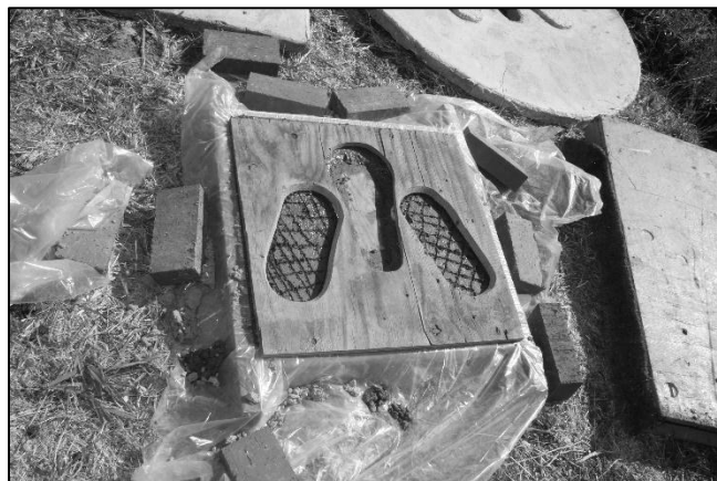
Guide en bois artisanal pour positionner le repose-pieds au bon endroit (gauche) ; traçage de la position des repose-pieds à l'aide du guide (droite)
