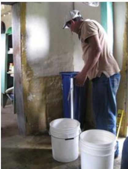
Instalación del filtro de plástico
