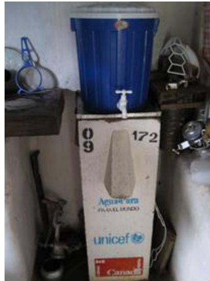
FBA de concreto de APPM, Honduras
