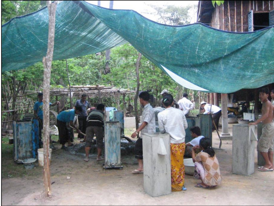
Construcción de filtros de bioarena (Fuente: Clear Cambodia)
