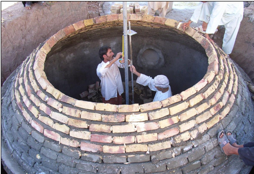
Digestor anaeróbico en construcción en Afganistán (Fuente: SuSanA)
