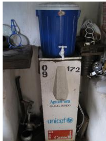
Un FBS à boîtier béton APPM, Honduras
