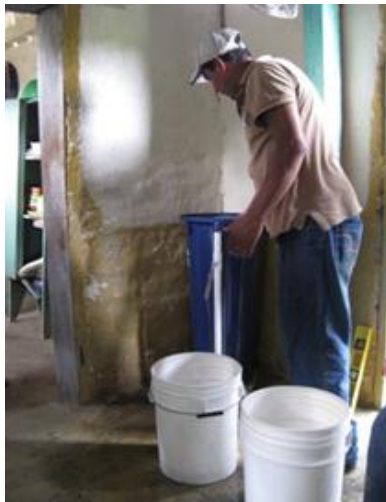
L'installation du filtre à boîtier plastique
