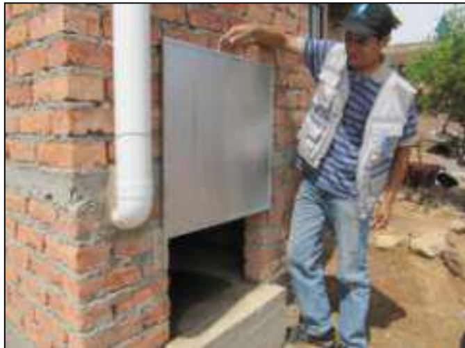
Construcción de letrinas de compostaje, Bolivia (Fuente: Aquatuya)
