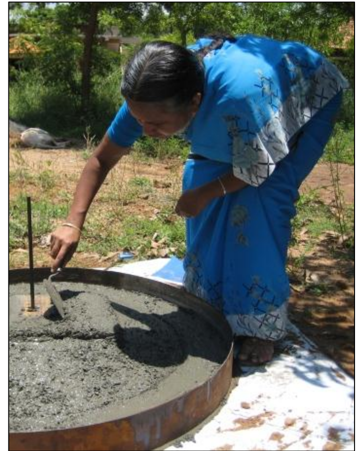
Capacitación de CAWST sobre cómo construir una losa de letrina, India
