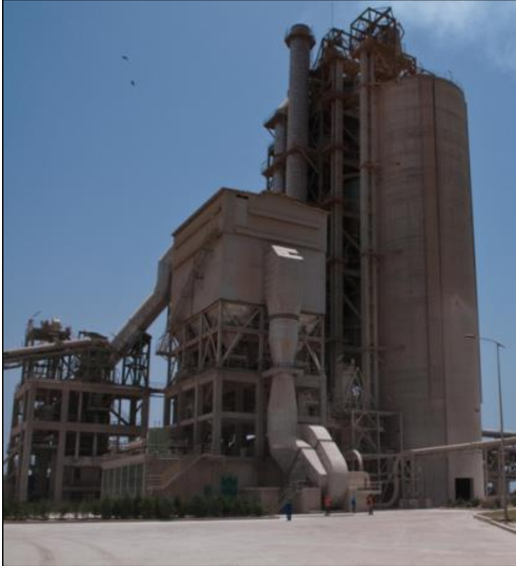
Industria de cemento en Dakar, Senegal (Fuente: Eawag-Sandec)
