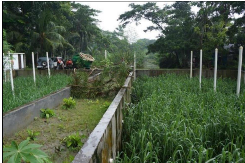
Lits de séchage planté au Bangladesh (Source : Blog de recherche appliquée sur la gestion des boues de vidange (FSM))
