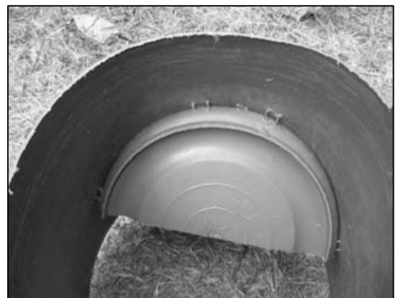
Étape 3. Attacher une moitié du fond à mi-hauteur du seau à l'aide d'un fil de fer. Le fond doit être incliné pour recueillir l'urine.
