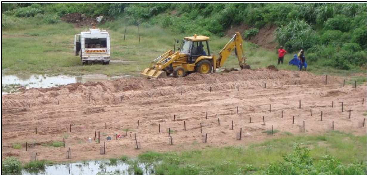
Tranchées profondes de boues de vidange de latrines à fosse à Durban, Afrique du Sud (Source : Jay Bhagwan, Water Research Council South Africa in Strande et al., 2014)
