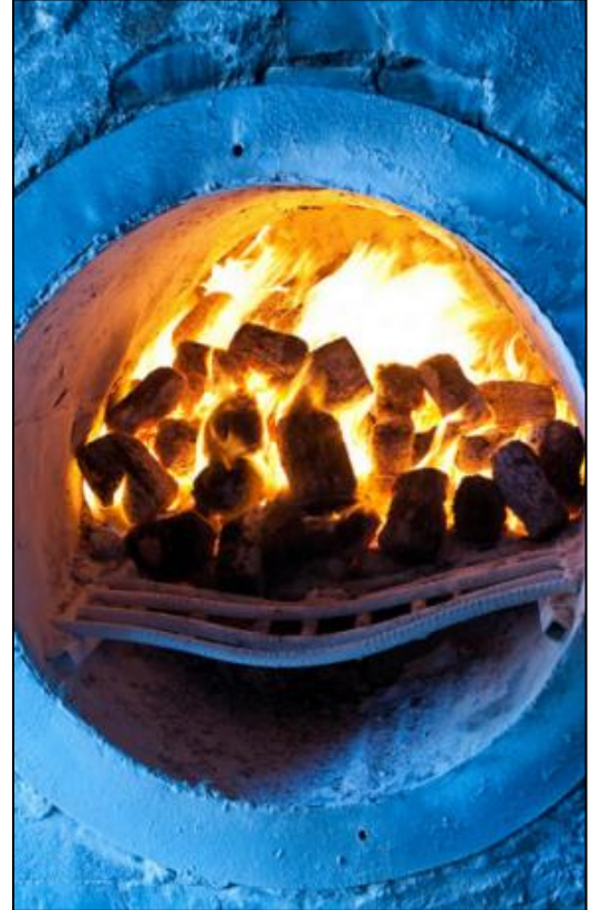
Four utilisé pour sécher les produits à base d'argile Kampala, Uganda (Source : Eawag-Sandec)
