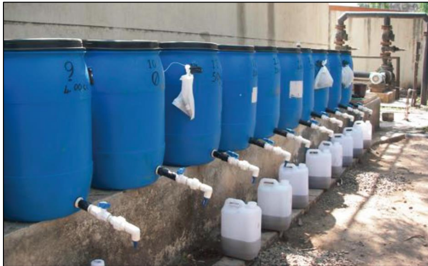
Los recipientes para lombrifiltración en un proyecto piloto en India (Fuente: IFRC)
