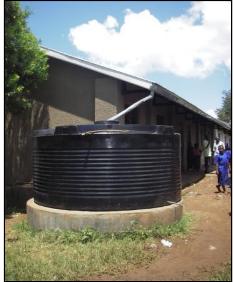
Une citerne d'eau de pluie
