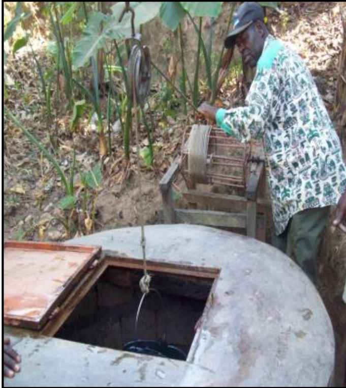
Un puits protégé
