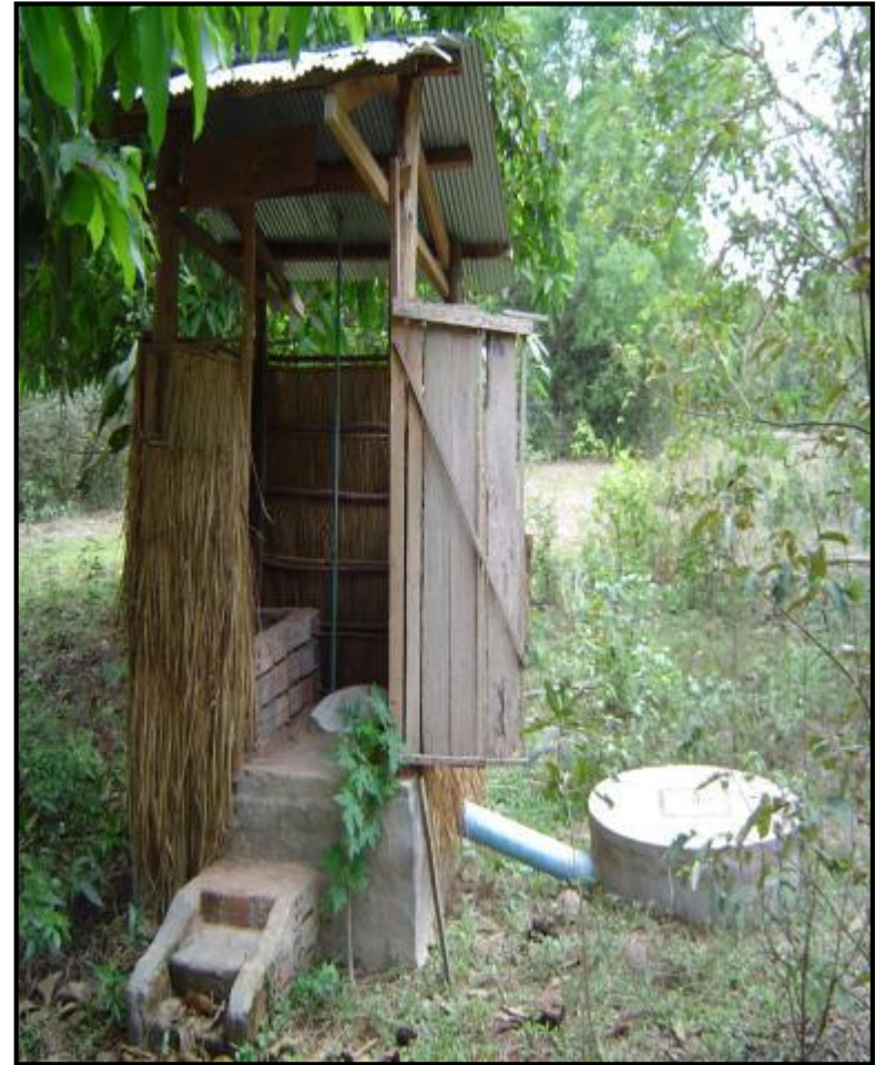
La latrine à chasse manuelle
