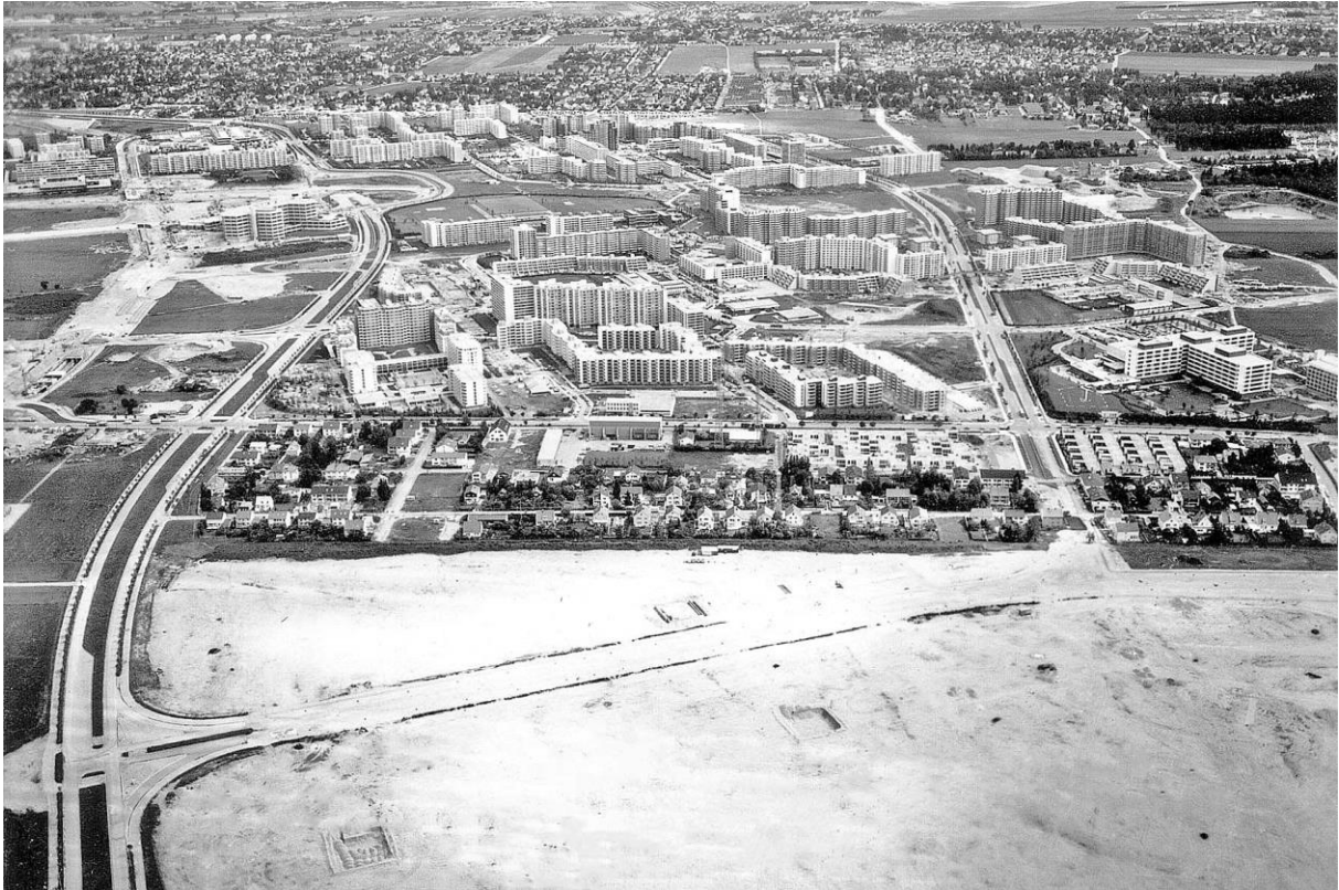
Figure 1 Street Network in newly constructed Neuperlach (Image Source Karl Schillinger, 1974; https://www.muenchenwiki.de/wiki/Neuperlach#/media/Datei:Neuperlach.jpg )
