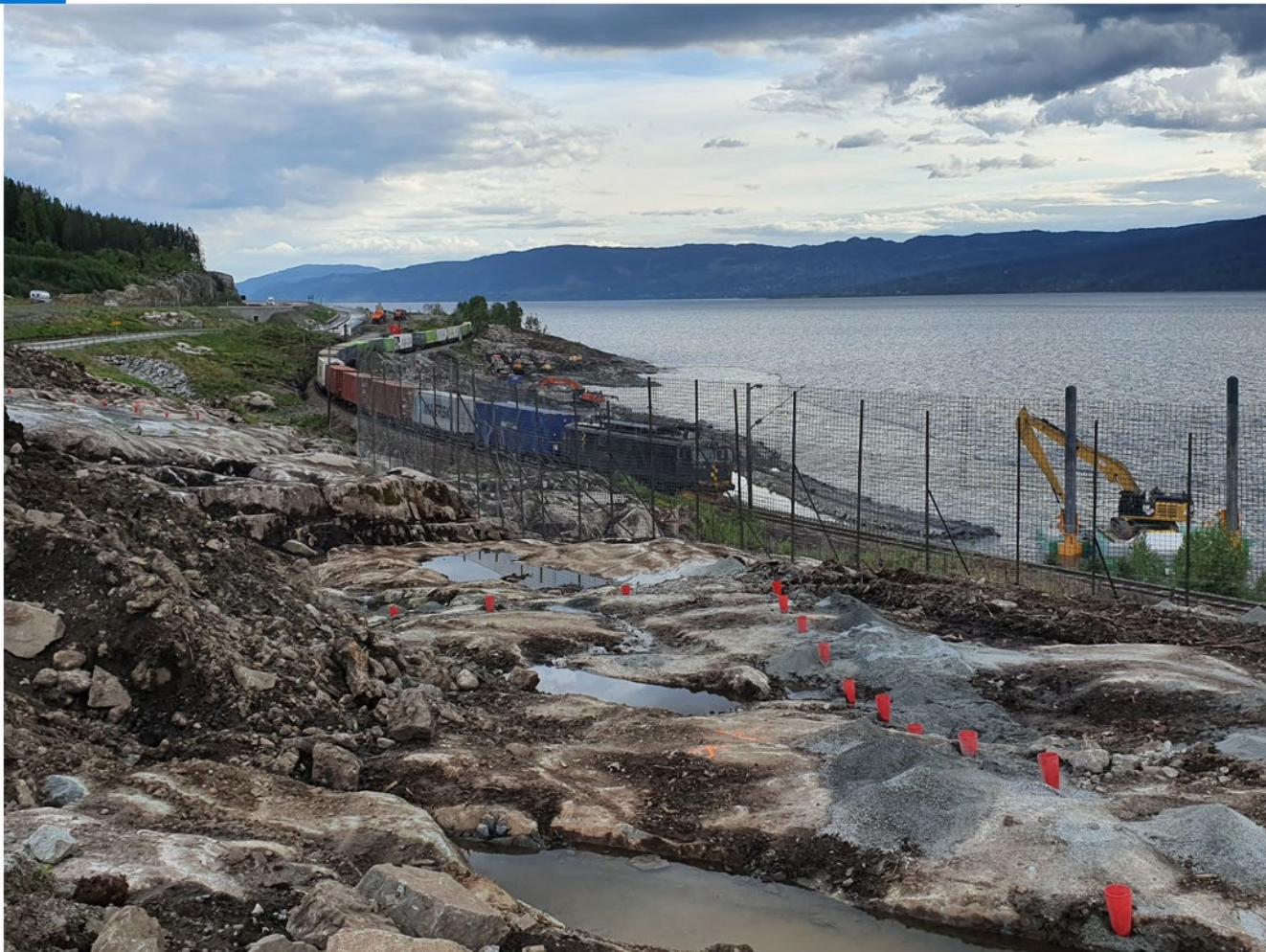
KS-1 Hestnestunnelen, kontrakt med Veidekke
